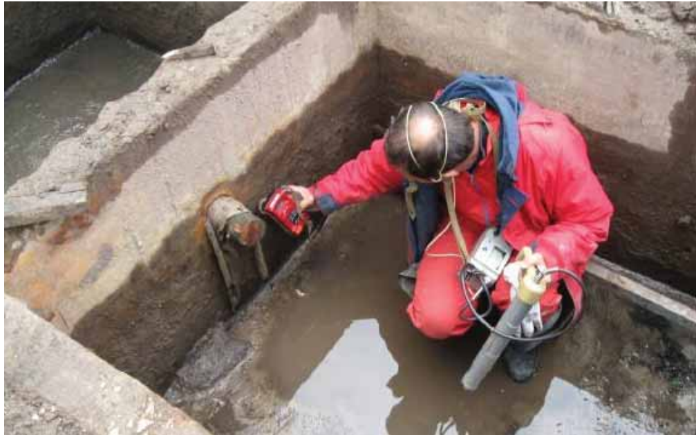
Бетонные емкости очищены от радиоактивных отходов и дезактивированы. Перед тем, как их разрушить и вывезти на захоронение, проводится радиометрический контроль. Фото предоставлено Комитетом по природопользованию Санкт-Петербурга
