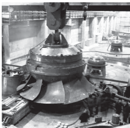
Уникальная поворотно-лопастная турбина.
