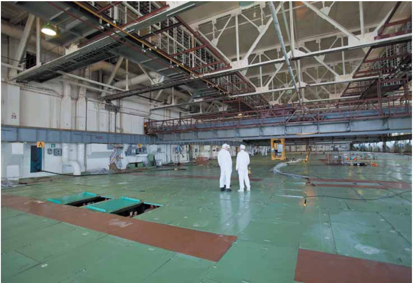
ПО «Маяк»: общий вид цеха, под полом которого находится бассейн для хранения сборок с отработавшим ядерным топливом. Россия, Челябинская область. Фото: Илья Яковлев/ИТАР-ТАСС
