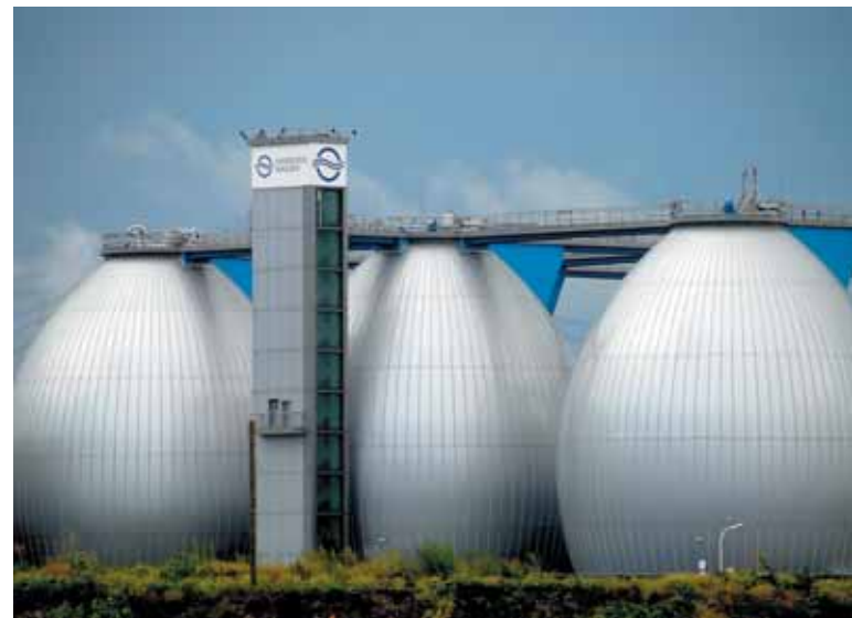
Из отходов очистки сточных вод получают биогаз, используя его для энергоснабжения самой очистной системы. На фото: водные резервуары компании по водоснабжению и водоотведению Hamburg Wasser. Фото: Rob Deutscher, flickr.com
