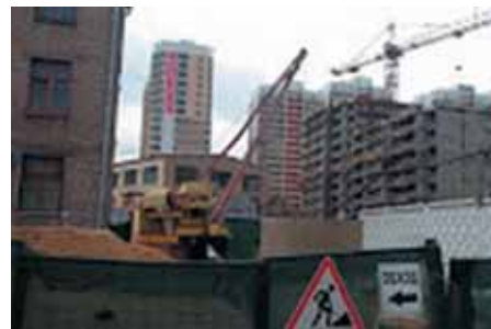
На месте старого завода ЖБИ на ул. Мельникова строят высокотэтажный жилой комплекс. Фото: Наталья Парамонова, июль 2015 года
