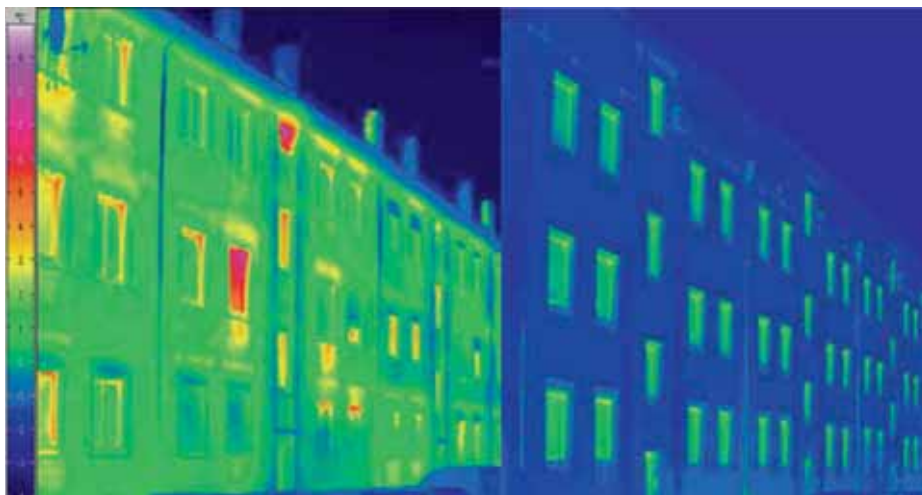
До (слева) и после (справа) энергоэффективной модернизации. На термографических изображениях виден эффект от предотвращения теплопотерь в пассивном доме. Фото: www.passivehouse-database.org
