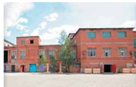
Здание московского арт-пространства «Флакон» – бывшего завода по производству хрустальных флаконов – до передачи новым собственникам. Фотография предоставлена дизайн-заводом «Флакон»
