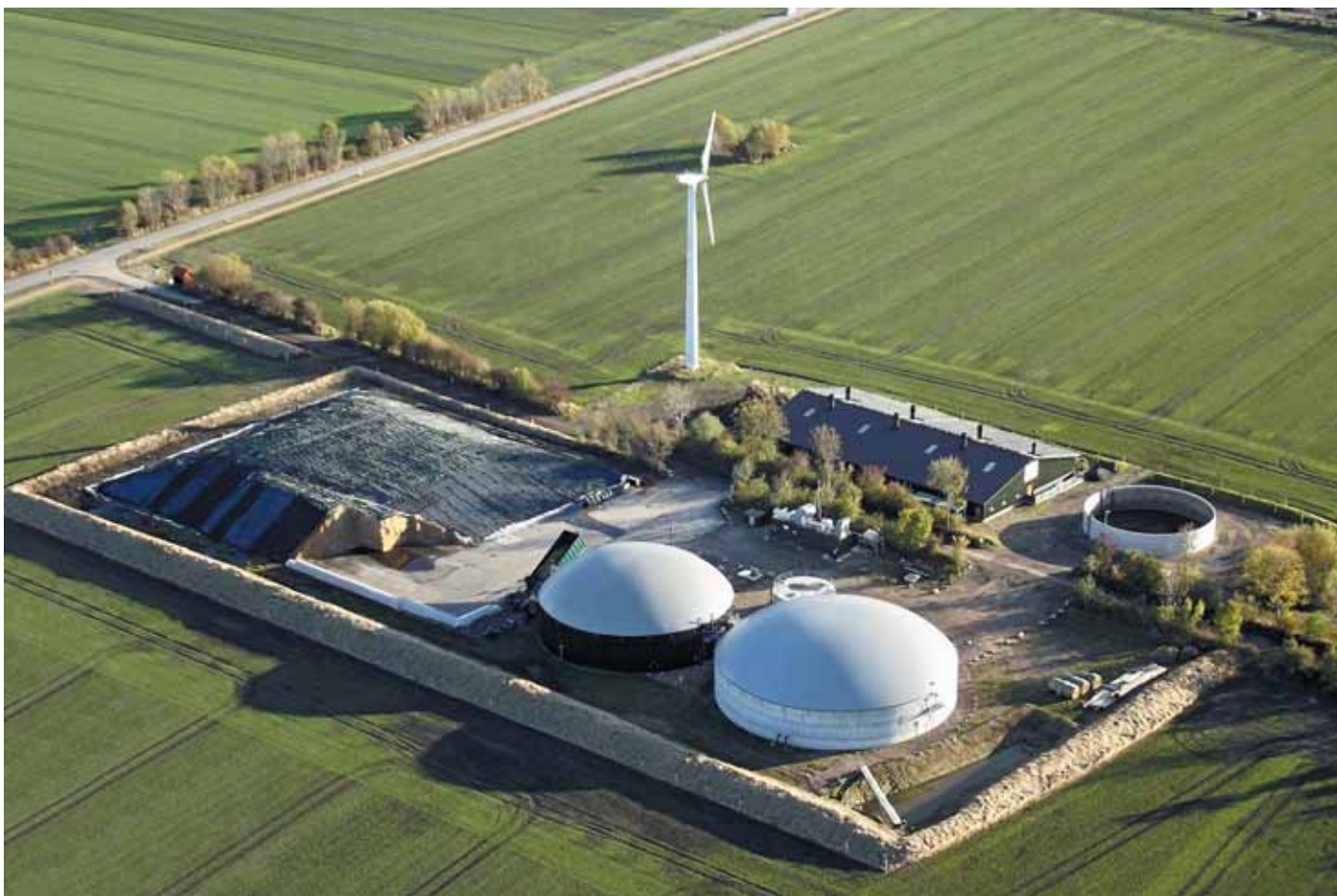
Завод по производству биогаза.
