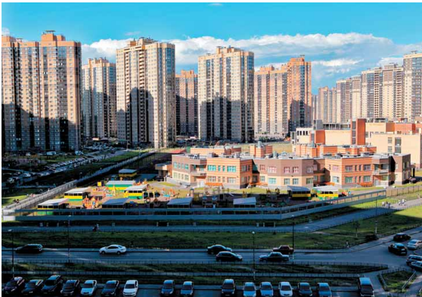
Петербург, новый жилой комплекс «Северная Долина». На переднем плане – здания детского сада и школы.
