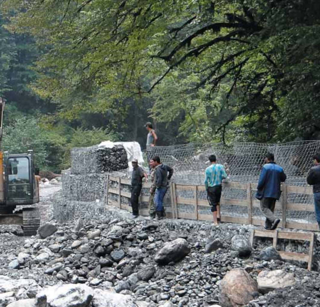
Дорожную «подушку» отсыпали гравием, который добывали тут же – из русла реки Шахе. Шахе – одно из последних на Черноморском побережье нерестилиц черноморской кумжи, занесенной в Красную книгу РФ. После того как со стройки удалили рабочих-мигрантов, темпы работ резко снизились, а прошедшие на реке паводки разрушили дорогу на нескольких участках. Фото: Владимир Кимаев / «Экологическая вахта по Северному Кавказу»
