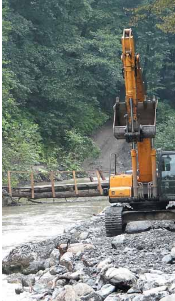
На строительстве южной дороги от Сочи к курорту «Лунная Поляна».
