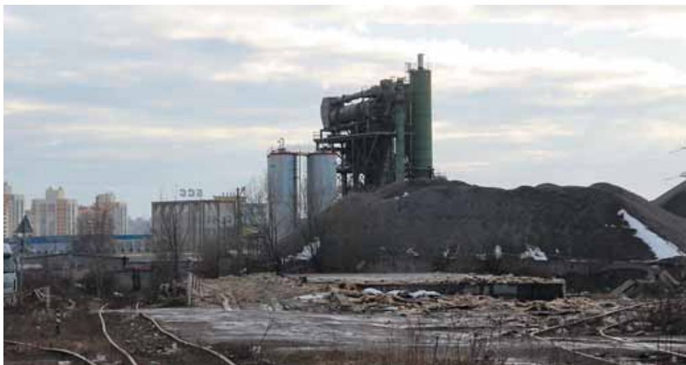
Промзона в Коломягах отравляет воздух жилых районов на севере Петербурга. Фото: abnews.ru
