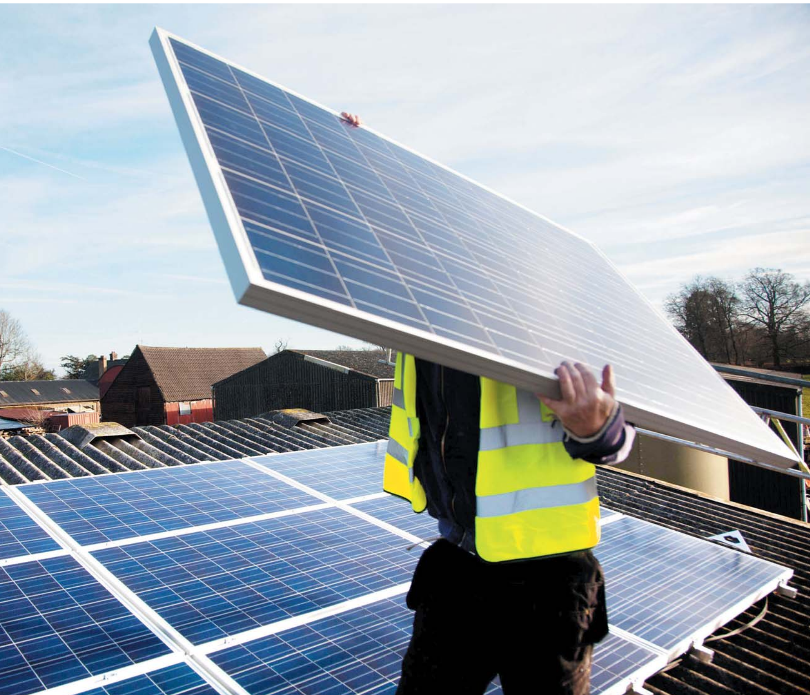
Установка солнечных панелей на крыше фермы, Балкомб, Великобритания.
