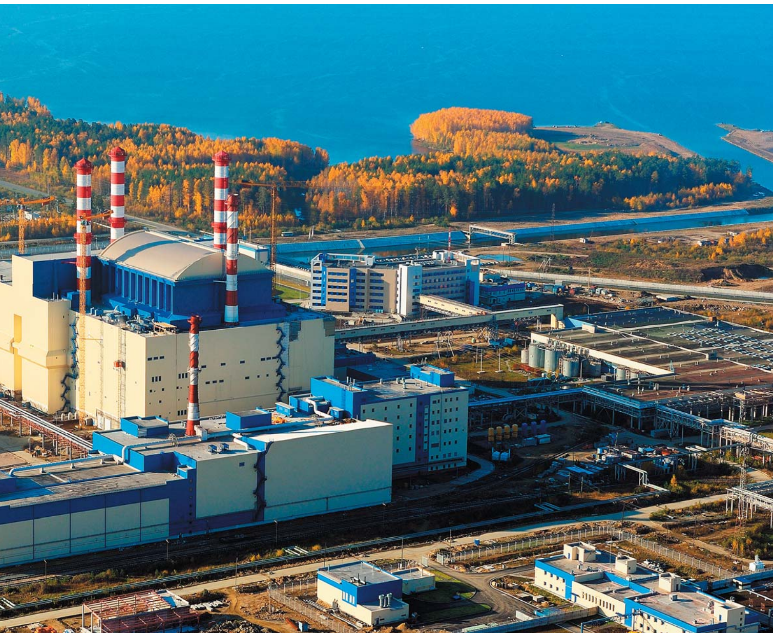
Белоярская АЭС: 1-й и 2-й блоки остановлены (в 1981 и 1989 годах соответственно), но не выведены из эксплуатации.
