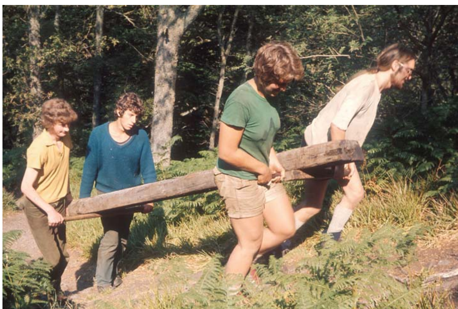
Строительство пешеходной тропы в Лох-Ломонде, Шотландия, 1975 год. Фото: Alan Brooks / The Conservation Volunteers / flickr.com
