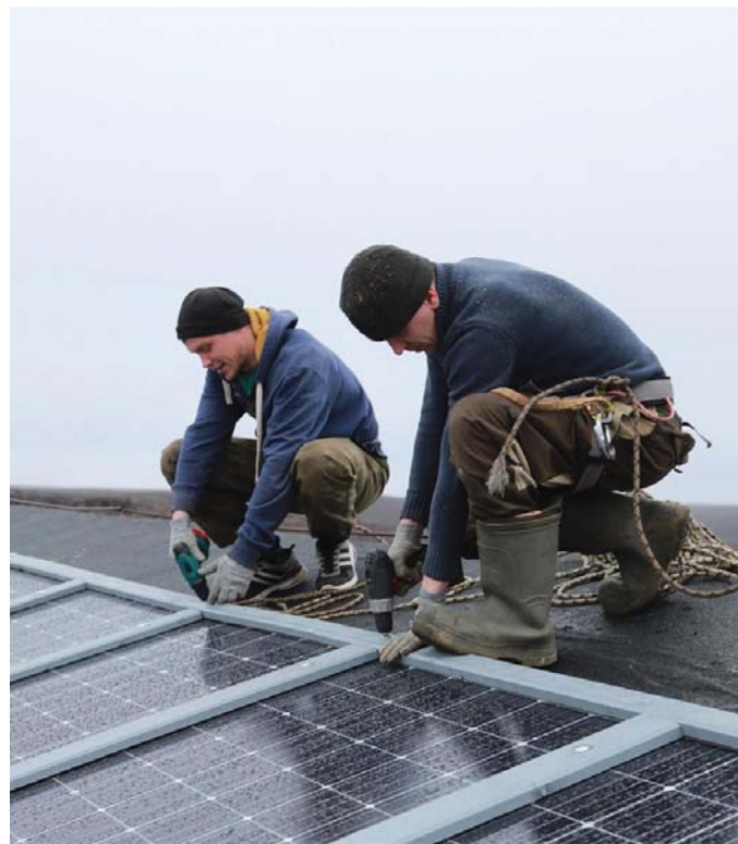
Монтаж системы альтернативной энергетики на полевой базе. Национальный парк «Русская Арктика», остров Земля Александры. Фото: Александр Кулешов / www.rus-arc.org
