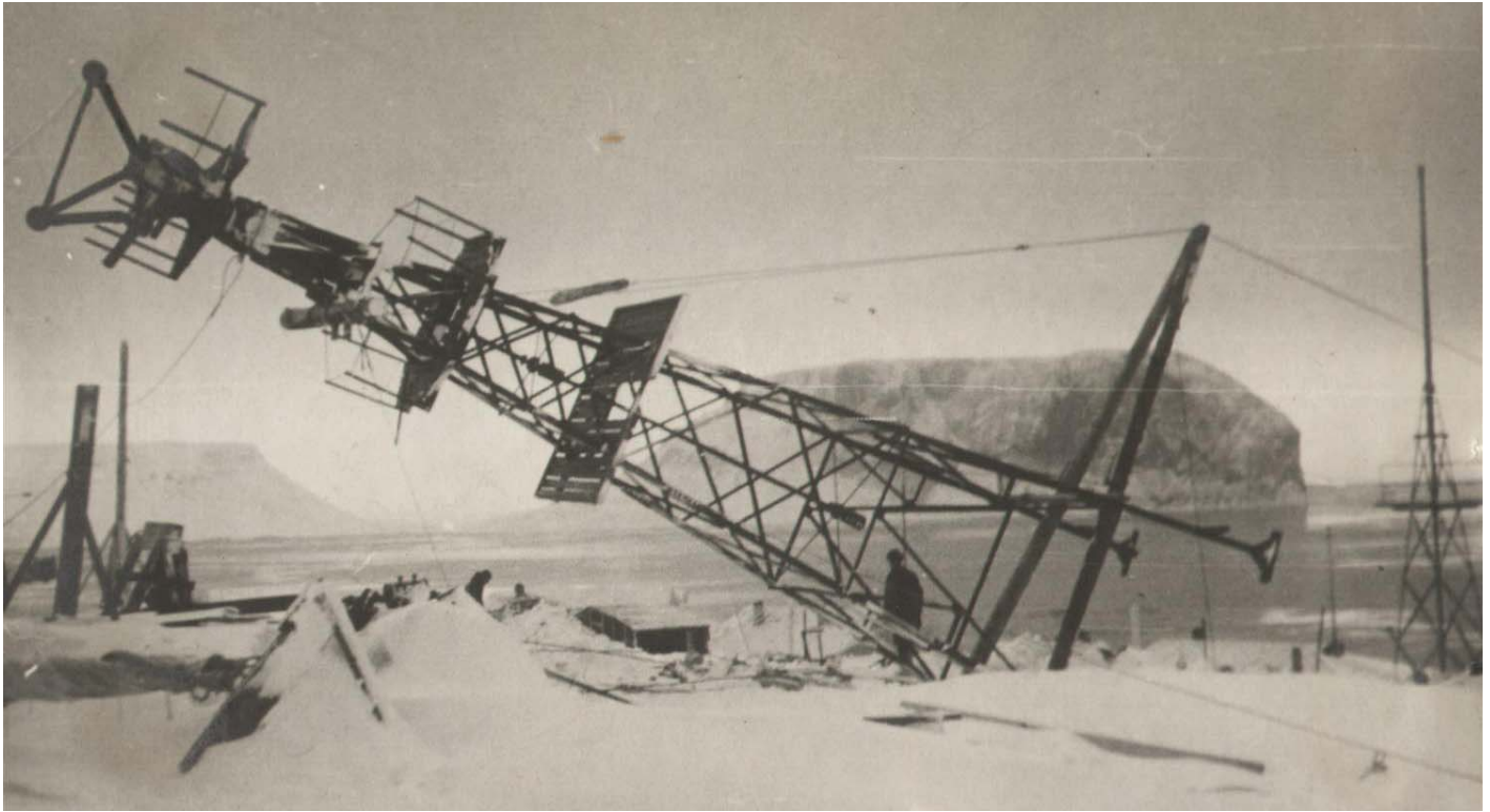
Установка ветродвигателя Д-12 на советской полярной станции Бухта Тихая в декабре 1939 года. Ветрогенератор был основным источником электроэнергии для полярников, активно использовался в годы Великой Отечественной войны и работал на станции почти до ее закрытия в конце 1950-х годов. Фото: www.rus-arc.ru
