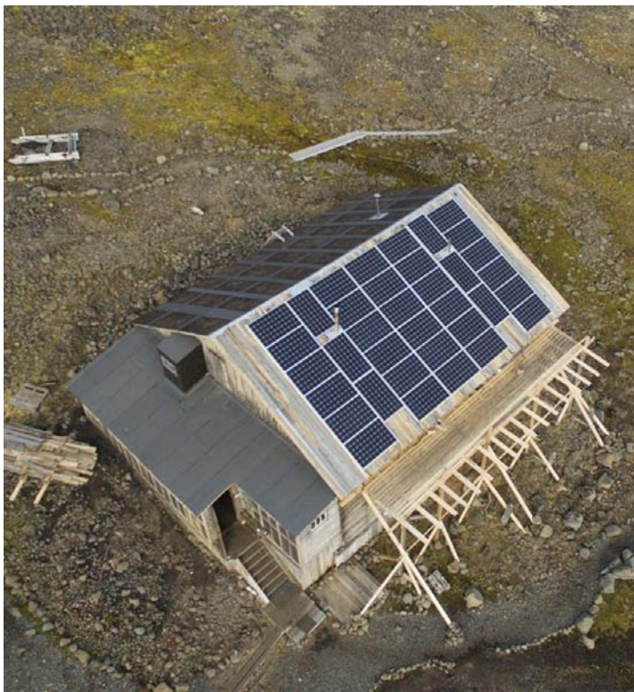
Солнечные панели на острове Гукера для обеспечения электричеством полевой базы «Бухта Тихая». Национальный парк «Русская Арктика». Фото: Николай Гернет / www.rus-arc.org
