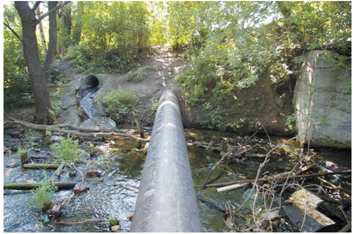
Оголовок № 1 выпуска сточных вод с очистных сооружений хозфекальной канализации города Дмитровграда в Куйбышевское водохранилище.
