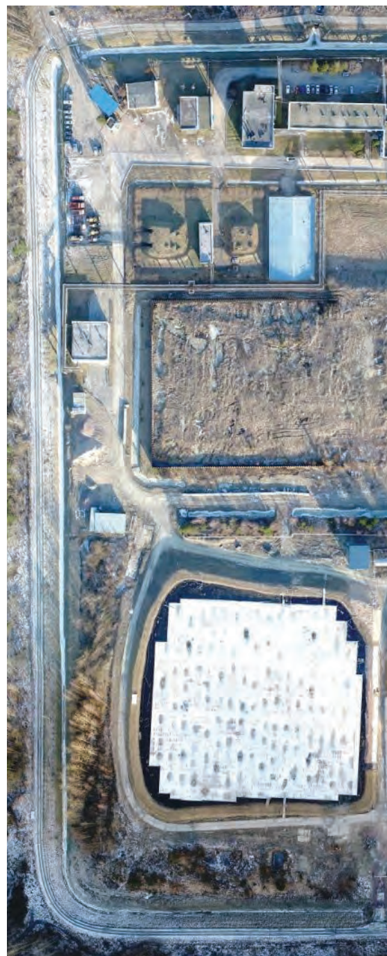
Фото: ФГКУ «Дирекция по организации работ по ликвидации накопленного вреда окружающей среде, а также по обеспечению безопасности гидротехнических сооружений полигона «Красный Бор».
