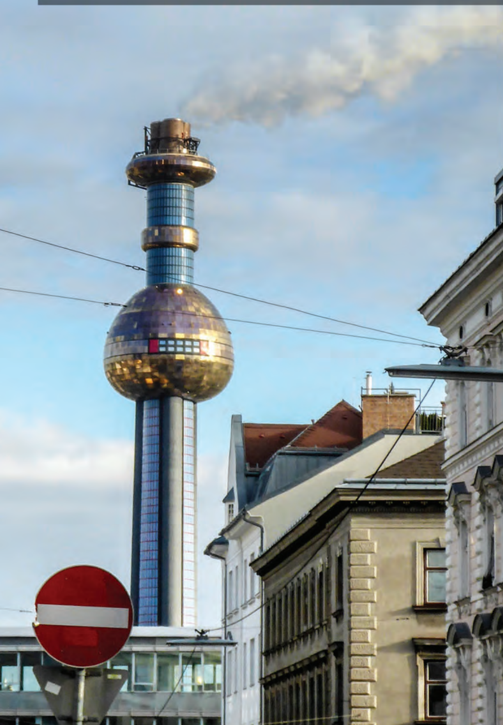
Труба мусоросжигательного завода Шпиттелуа в Вене. Фото: Н. КоPP/flickr.com
