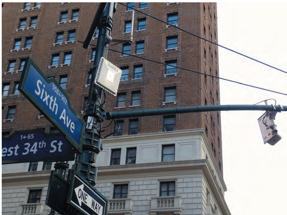
Считыватель электронной системы взимания платы за проезд, прикрепленный к веже и ее антенне (справа), используется для мониторинга дорожного движения в Нью-Йорке. Фото: z22 / wikipedia.org
