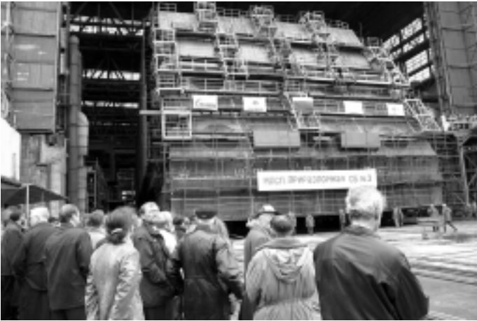
Вывод суперблока «Приразломной» из цеха
