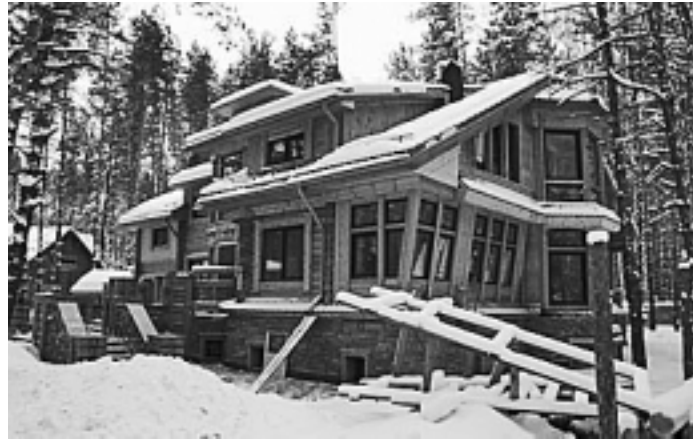
Одна из строящихся в Зеленом городе дач фото: Михаил Шибаров
