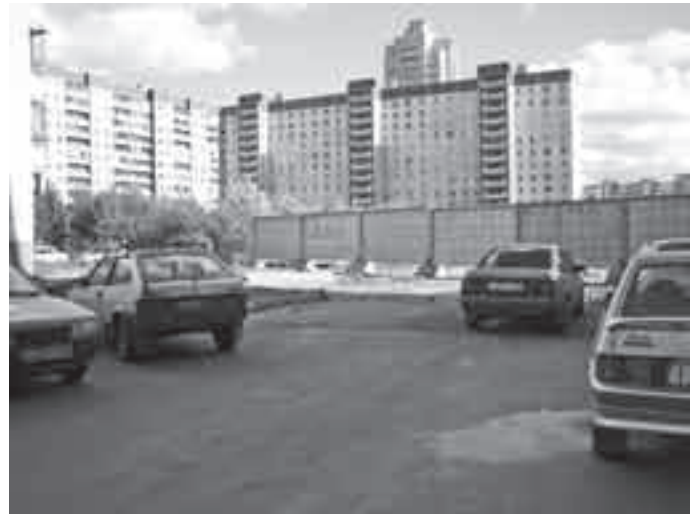
Забор новой стройки находится прямо во дворе дома
