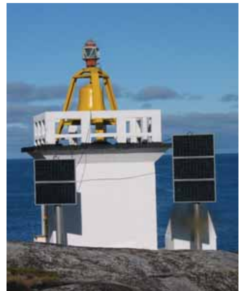
Маяки вдоль трассы Северного морского пути переносятся с радиоизотопных источников энергии на возобновляемые
