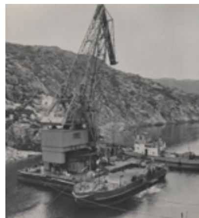
Подготовка основания для первого блока станции
