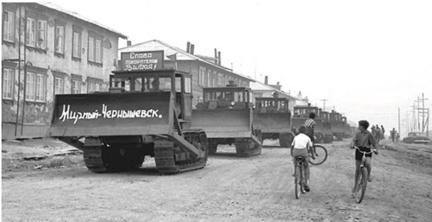
1962 год. На строительство Вилюйской ГЭС прибыла колонна бульдозеров. Фото: © Виктор Макаров
