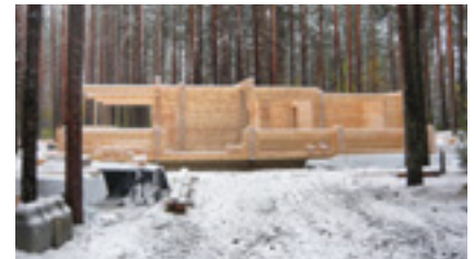
ООО «Свобода Моторс» утверждает, что здания комплекса являются некапитальными сооружениями и могут быть демонтированы без ущерба для окружающей среды.
