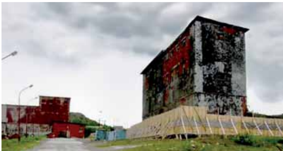
Основная дорога, по которой перемещались грузы, в том числе и ОЯТ. Вид на здание № 1 (справа) и здание № 5 (слева вдали). Здание № 1 и БСХ обнесены новым забором, который не позволяет видеть базу подводных лодок Западной Лицы. Строители заборов не учли, что через Интернет можно получать спутниковую информацию о том, что происходит в любой точке Земли, в том числе и в Западной Лице. Фото из архива «Беллоны»
