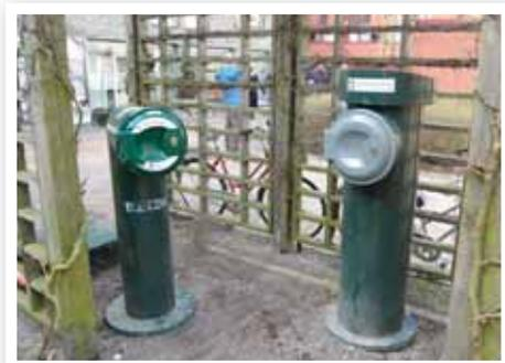
↑ Автоматическая подземная система сбора бытовых отходов для последующей переработки.
