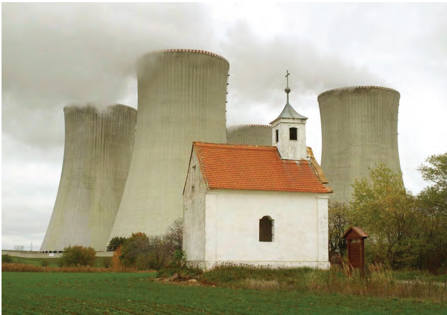
Осенью 2022 года Чехия официально приступила к отбору предложений для строительства еще одного крупного, до 1,2 ГВт, энергоблока на АЭС «Дукованы». На фото: АЭС «Дукованы», Чехия.
